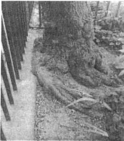
5. ábra: Felszínre került, sérült gyökér, fojtógyökér, kerítés alapozásába nőtt gyökérnyak
